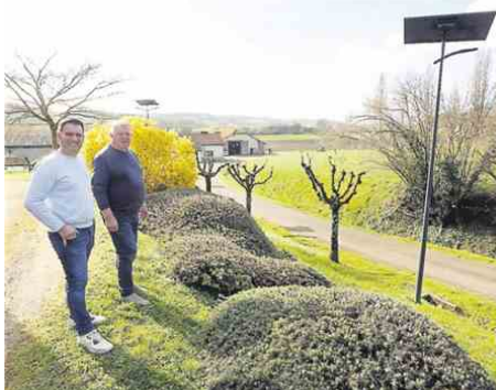
Pierre Vieillevigne (à droite) et son adjoint Julien Poujal ont fait installer 23 mâts solaires pour assurer l'éclairage public du centre bourg et de ses hameaux. / DDM, Manu Massip.
