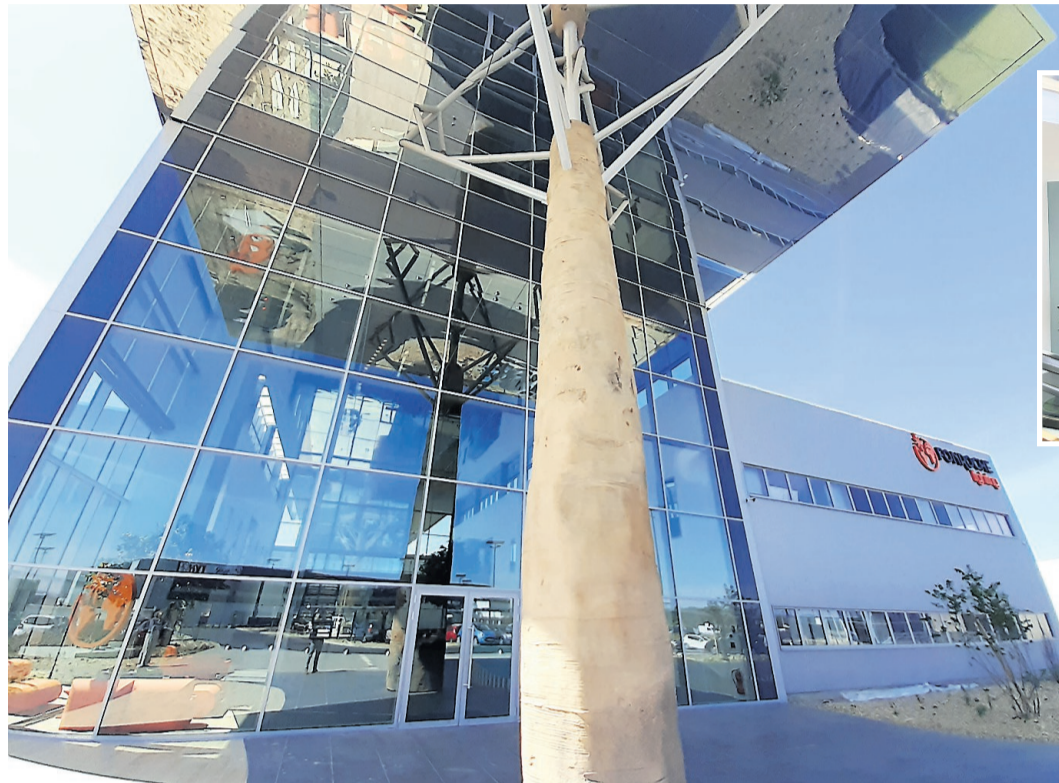
Le site de « La Street » a été conçu par l'architecte agenais François de la Serre./ photos SBo
