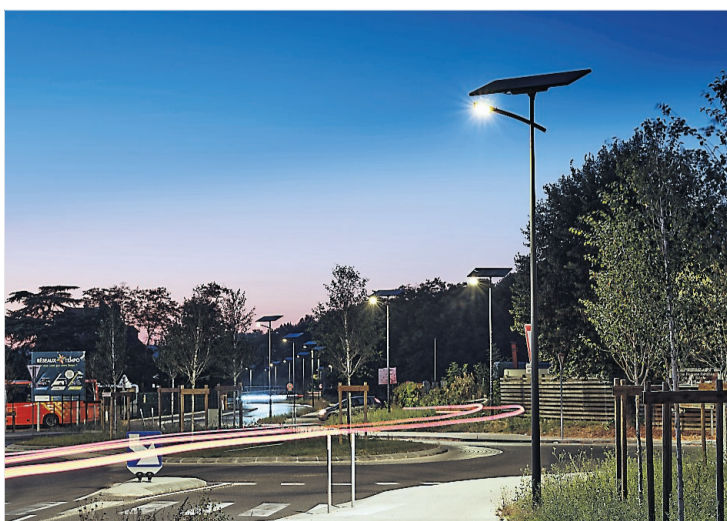
Plus de 3 000 communes en France ont fait le choix de l'éclairage durable, comme ici à Bon-Encontre./crédit Fonroche lighting/Julien Domec
