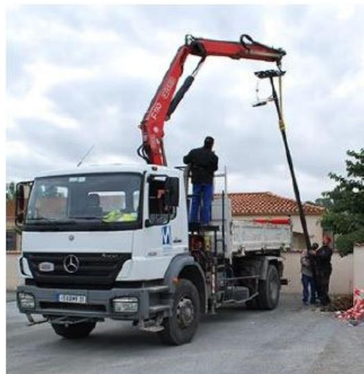
**3** Finir le montage PV et batterie ainsi que le réglage orientation PV et crosse à la nacelle
